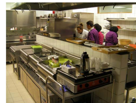
Die Lernküche wurde fertig gestellt und ist mittlerweile im Betrieb.
