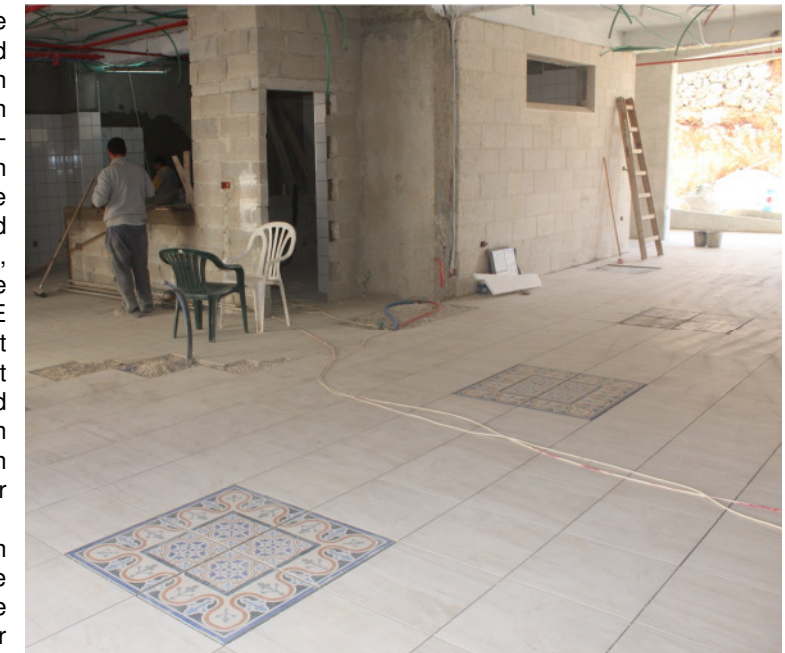
Der zukünftige Speisesaal im Rohbau
